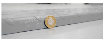
Próg nie przekraczający wysokości 25 mm!
